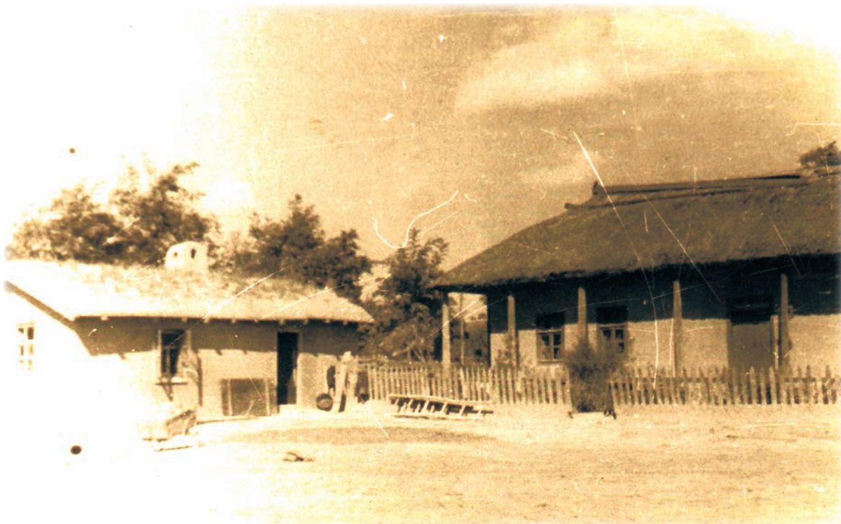
Двухкамерный дом начала XX века с камышовой крышей (архив М.В. Маруневич)
