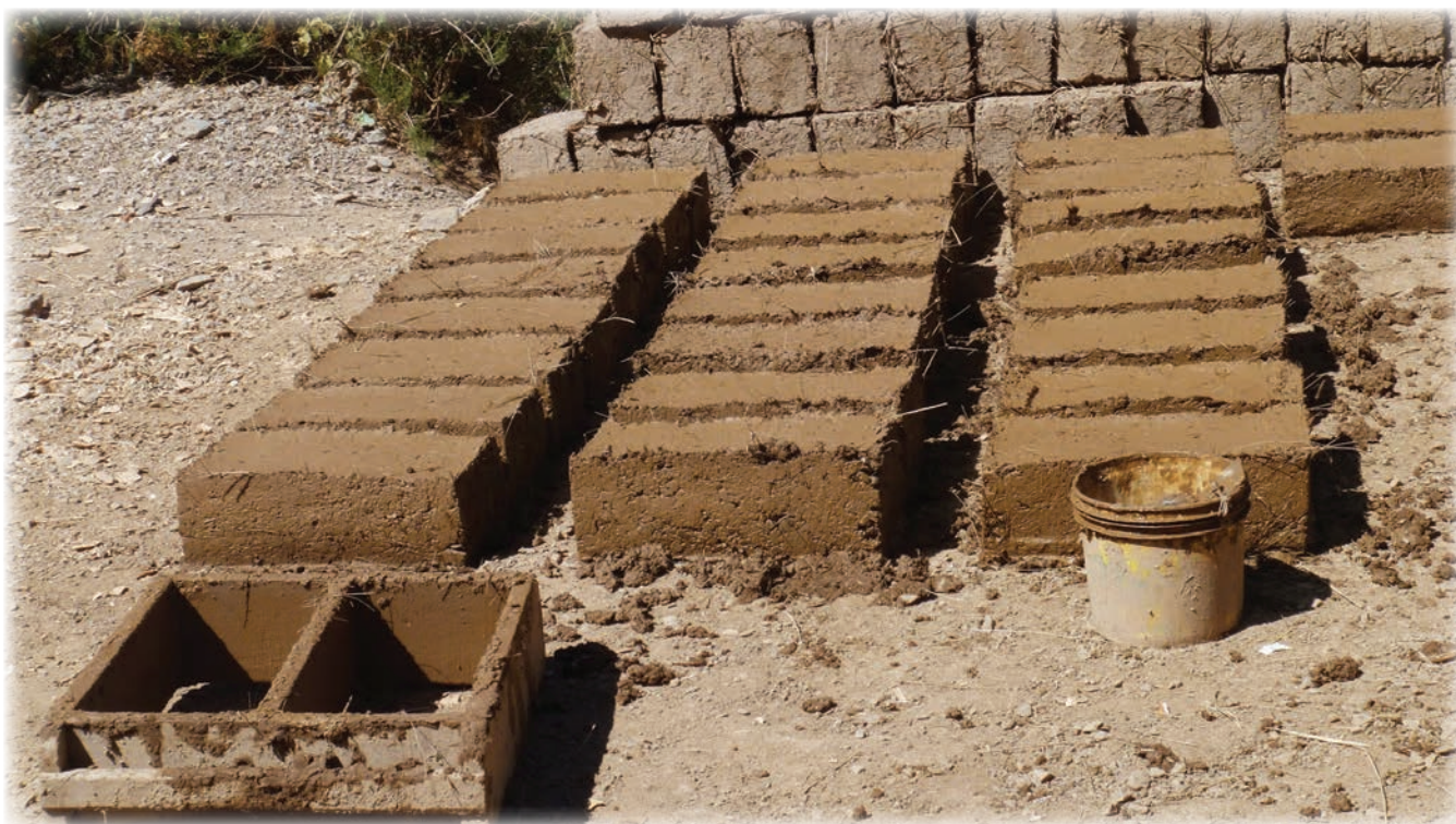
Только что отформованные саманные кирпичи на просушке Şindi yapılı saman kerpiçleri kurumakta
