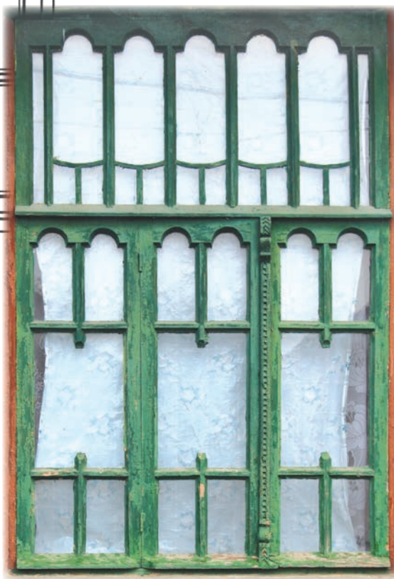
Pervazsız dekorativ oymalı elementlərlən kompozitziyaya görə zor pənçərə. Etuliya küüyü.
