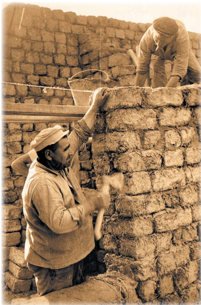
Процесс возведения стены дома (архив М.В. Маруневич) Duvarları kaldırmak (M.V. Maruneviç arhivi)
