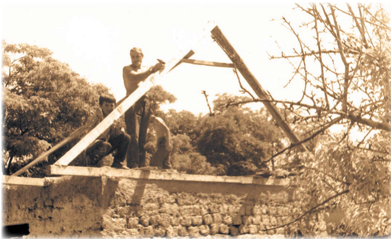
Монтаж крыши дома (архив М.В. Маруневич)
