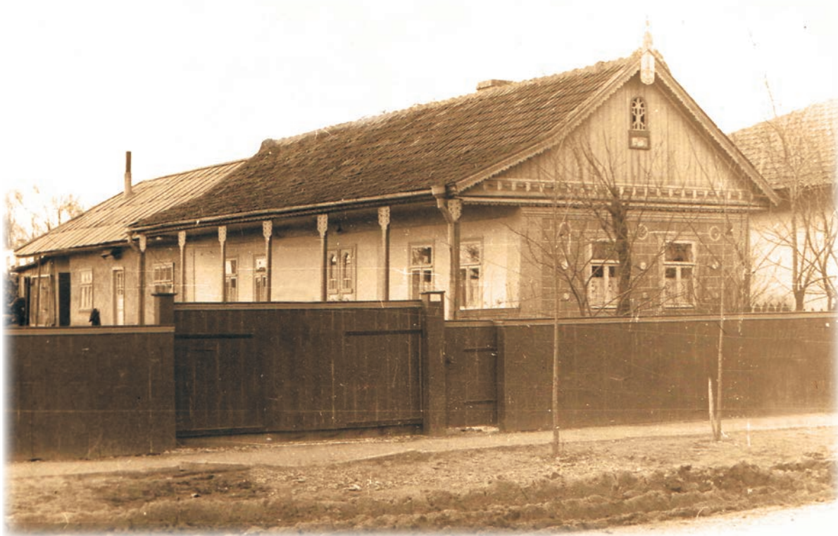
Двухкамерный дом середины XX века с комбинированной (цементной и глиняной) отделкой фасада и торца (архив М.В. Маруневич)
